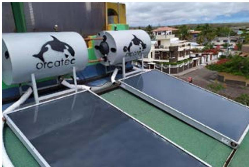
Figura 21. Imagen de dos sistemas solares térmicos Orcatec para el suministro de agua caliente. (Cortesía: Orcatec.ec)
